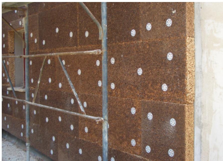
Isolamento esterno a cappotto in sughero (Foto: Studio Tecnico Ambiente)
