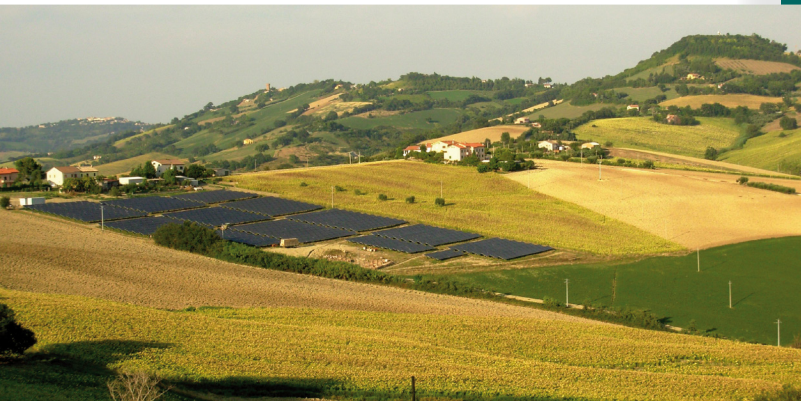
Impianto fotovoltaico a terra - Osimo (AN)
