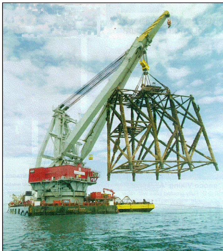
Figura 3-47: sollevamento completo di un jacket
