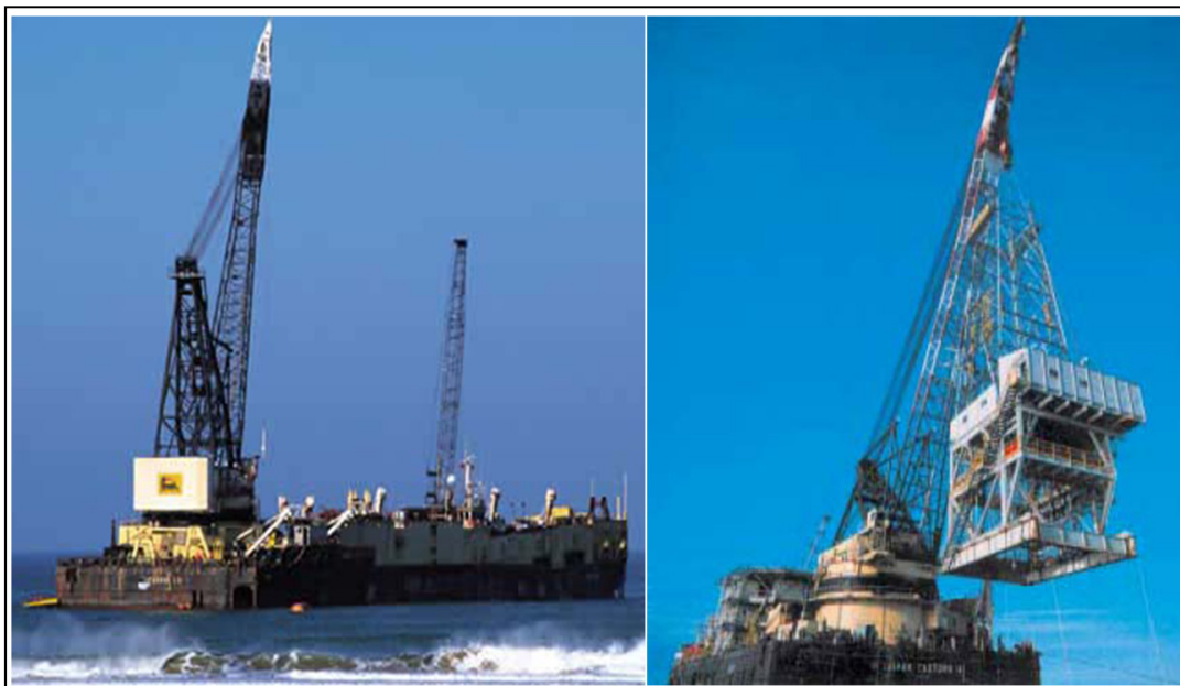
Figura 3-38: immagini del pontone di installazione della piattaforma (crane-barge)
