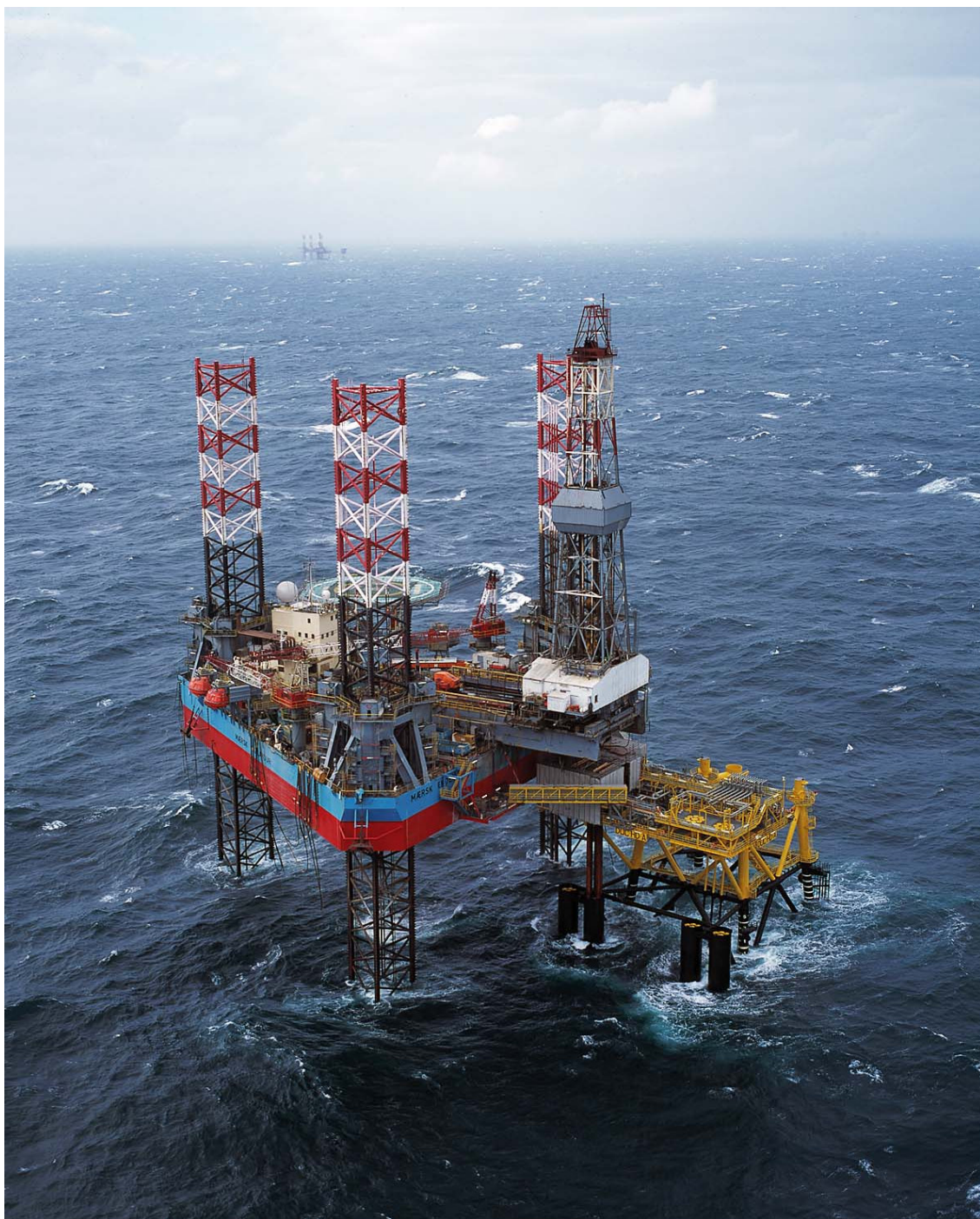
Figura 3-8: impianto Jack-Up Drilling Unit (tipo "GSF Key Manhattan")
