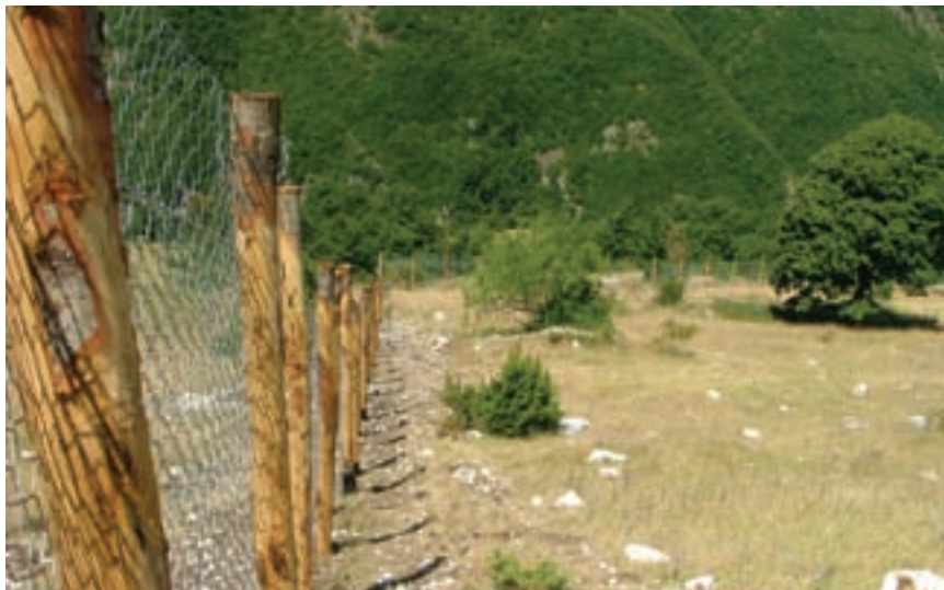
Fig. 75 – Recinzione fissa con rete metallica e pali in legno, non elettrificata, alta circa 2 m per lo stazzo notturno degli ovini, realizzata da parte dell'ASSAM nei pressi di Montecavallo (MC)(foto U. Testa).
